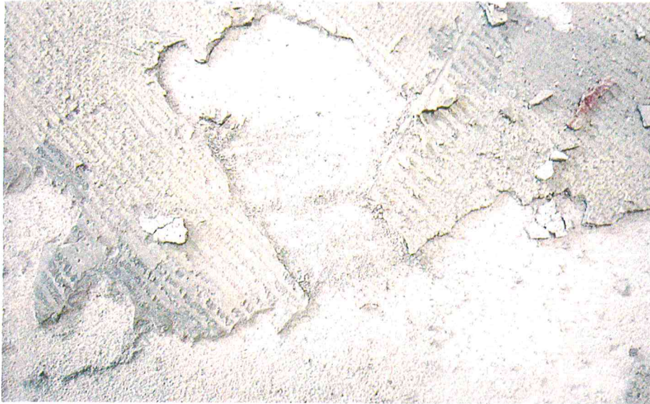
Altuntergrund 1: Das Bild zeigt einen Dispersionsklebstoff (Lino) und schwach anhaftende Spachtelschichten.
