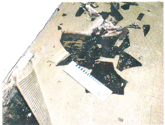
Die Fotos zeigen den alten, schwarzen Klebstoff, welcher ebenfalls im Verdacht steht, asbesthaltig zu sein, was sich bei der Prüfung bestätigt hat.
