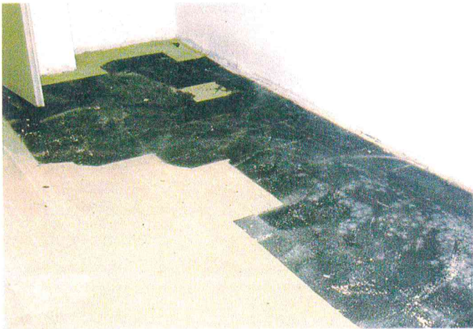
Die Fotos zeigen alte Flexplatten (asbesthaltig) mit schwarzem Klebstoff geklebt.
