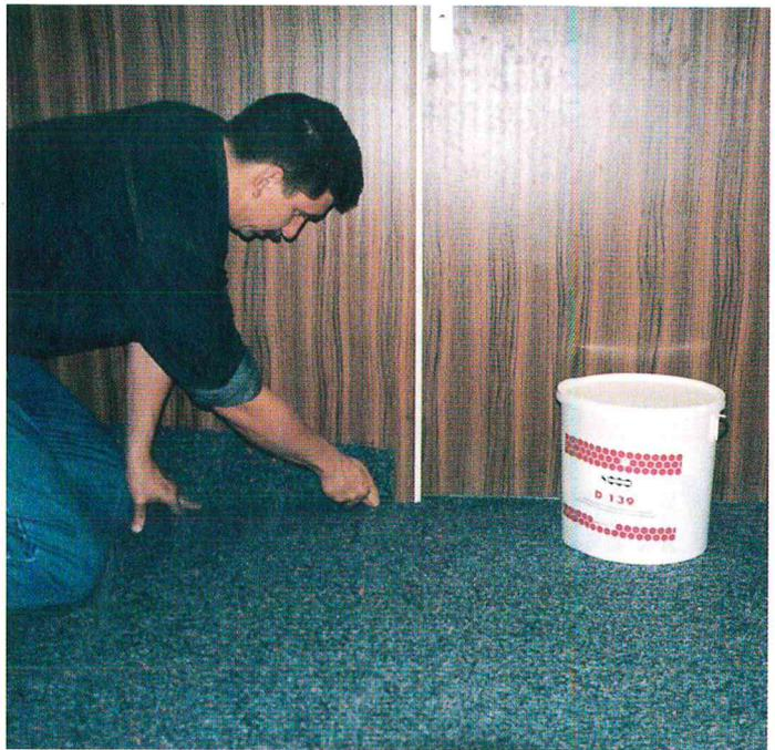
Der neue Kugelgarn-Teppichboden wird in das frische Kleberbett eingelegt und paßgenau zugeschnitten
